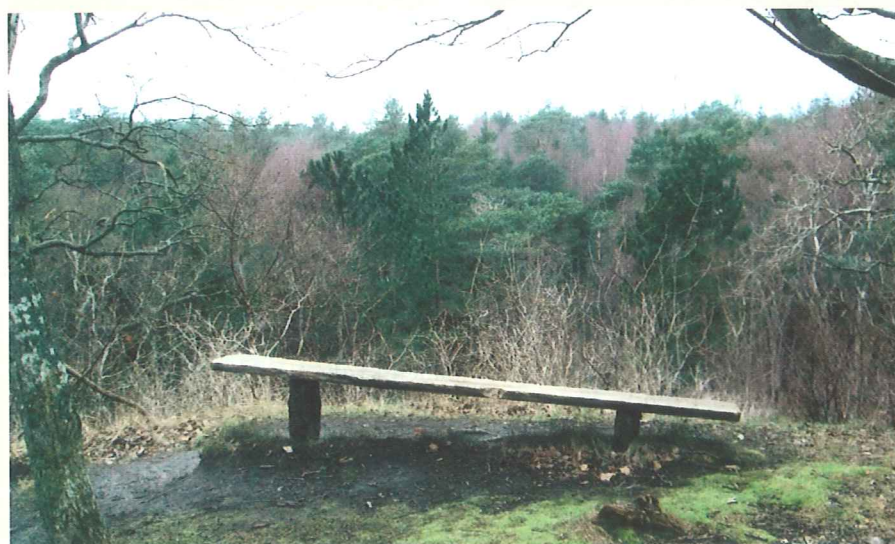
Bænk med udsigt over Kattegat. Den står skævt, fordi jorden omkring den ene pæl ikke er stampet lige så fast som omkring den anden pæl.
