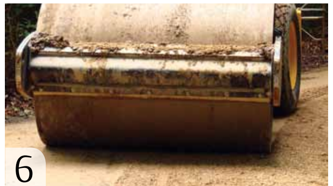
Udlæggeren sparer meget på grusmaterialerne. Men den vigtigste faktor er det perfekte forarbejde. Korrekt udlægning af vejsten og tromling sparer meget på gruset. Udlæggeren skal køre 3-4 gange hen over strækningerne for at få fastkørt sporene godt nok. Først herefter skal materialerne tromles fast.
