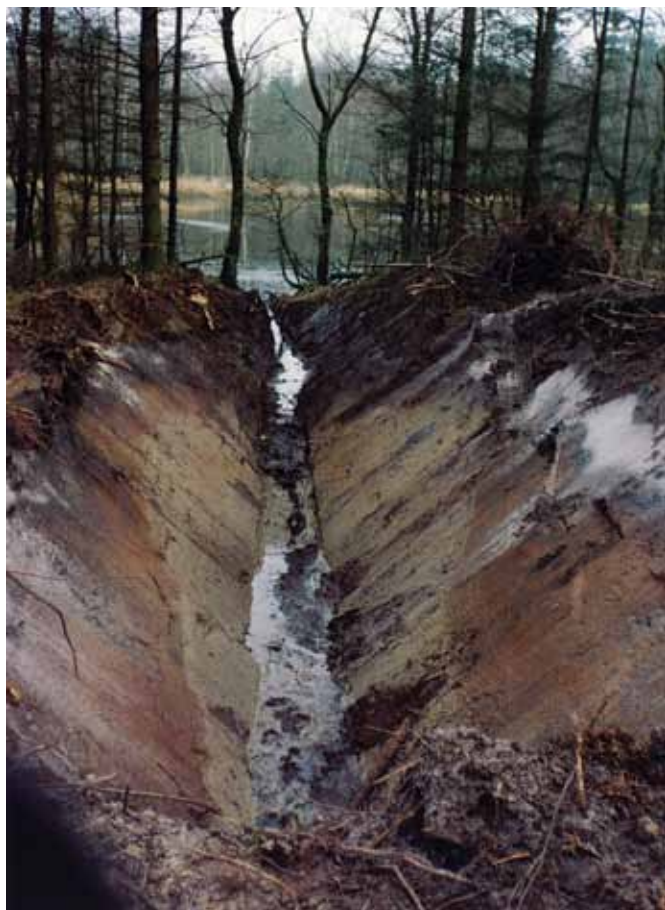
Før (1996): Nygravede grøfter. Foto: Skovejeren.
