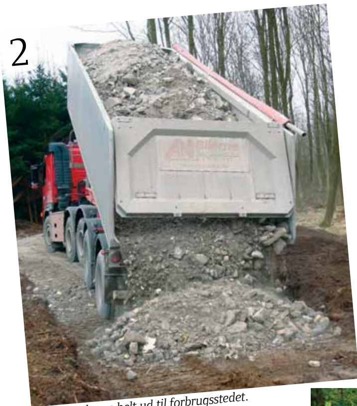
Materialerne jævnes og lægges straks i profil. Der tromles med bælterne, og der laves rabat. Bemærk at rabatten skal have samme profil som selve vejen, således at vandet kan løbe fra vejen. Det gør også, at man senere kan slå rabatten. Biler skal også kunne passere hinanden.
