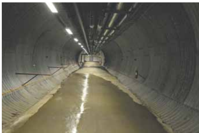
Her ses tunnelen, som fører ind til frølageret.
