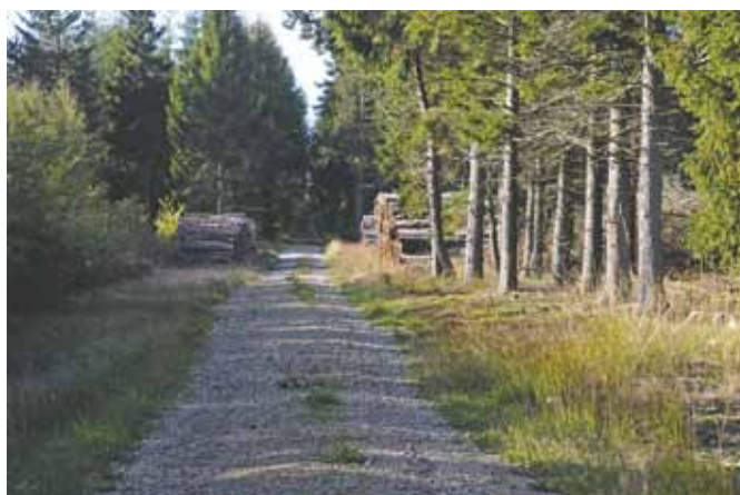
Den nord-syd gående vej gennem plantagen. 15 cm knust beton lagt med fin profil, så vejene er farbare hele året, og effekter kan hentes ud i al slags vejr.
