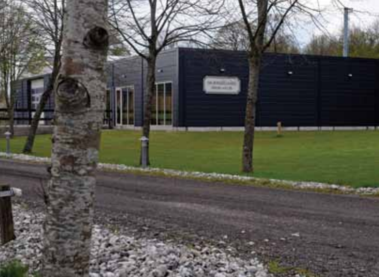
Bygningen med udsalg m.m. i stueetagen og med produktionsfaciliteter og lagring i kælderen.
