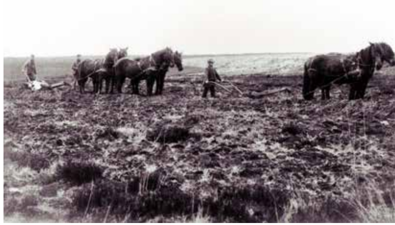
Reolpløjning i Gludsted plantage ca. 1900. Reolpløjning udførtes i to tempi: først en skrælpøjning af lyngskjolden med to heste, derpå selve reolpløjningen, med den svære plov forspændt fire heste.
