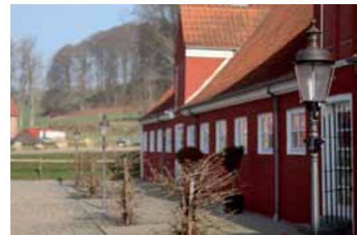
De gamle staldbygninger er renoveret og udlejes i dag til boliger og erhverv.
