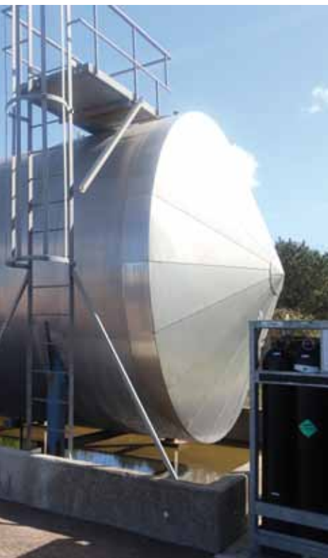
Tjæren opsamles i en stor udendørs lagertank. Det brændes af i en kedel i løbet af fyringssæsonen.
