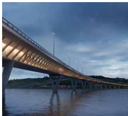
En kommende norsk motorvejsbro skal bygges med en trækonstruktion. Illustration: Selberg Arkitekter
