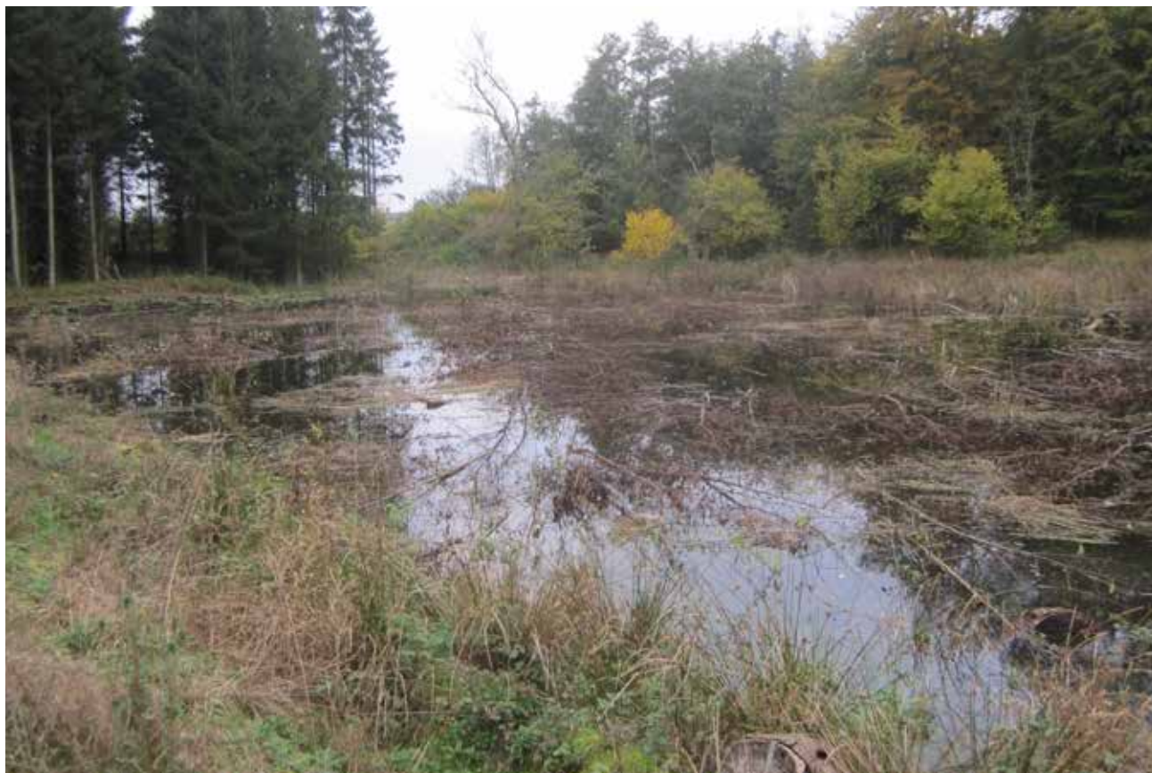
Skovsø anlagt med så simpelt et middel som en blokering af afløbet. 'Dæmningens' højde afgør søens udbredelse og dybde. Husk at etablere et afløb lidt under dæmningskronen, så den ikke i meget våde perioder overskylles og ødelægges.
