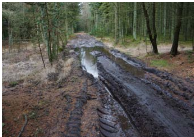
Skader på skovvejen efter et flisprojekt.
