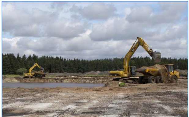
Sønderskoven: 'Hedesøen' anlægges i 2012. Der etableres mere end 2 ha vandspejl.
