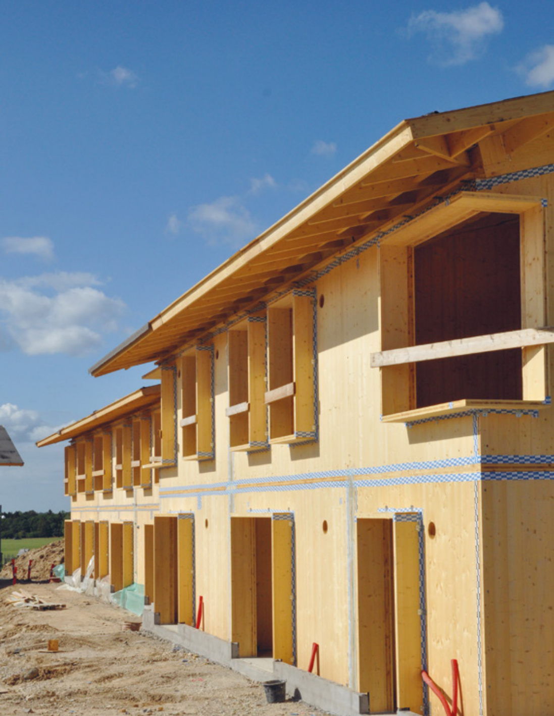
Boligbyggeri af træ i Skademosen ved Roskilde.
