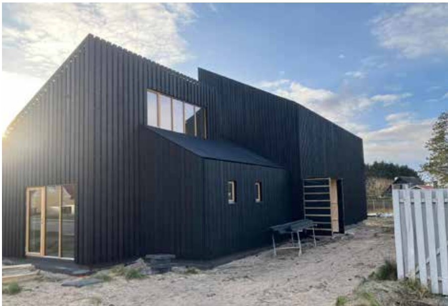
Woodfiber bygger også hele huse. Her er det et "Woodfiber-hus", tegnet af nokolova/aarsø og bygget af Keka Byg.
