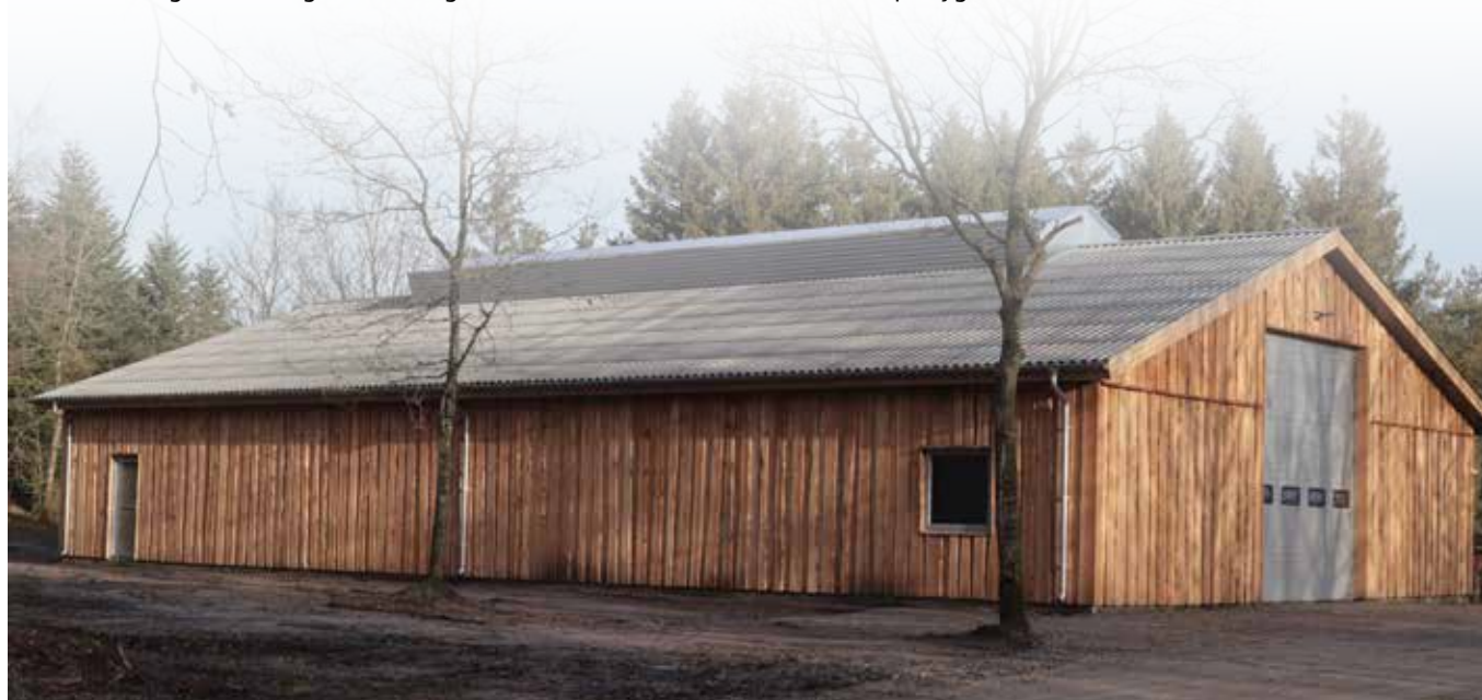
Maskinladen er bygget med indvendige stålspær og beklædt med kalmarbrædder, som er skåret af lærk fra egen skov.
