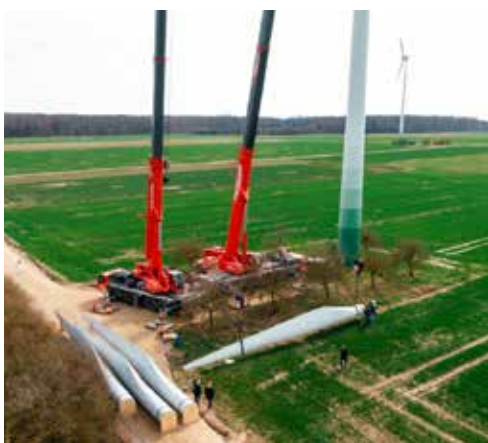
Opsætning af de nye vindmøllevinger af træ. Foto: Voodin
