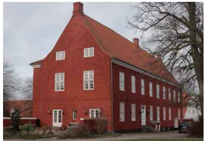
Hovedbygningen er bygget i 1500-tallet og gennemrenoveret i 00'erne.
