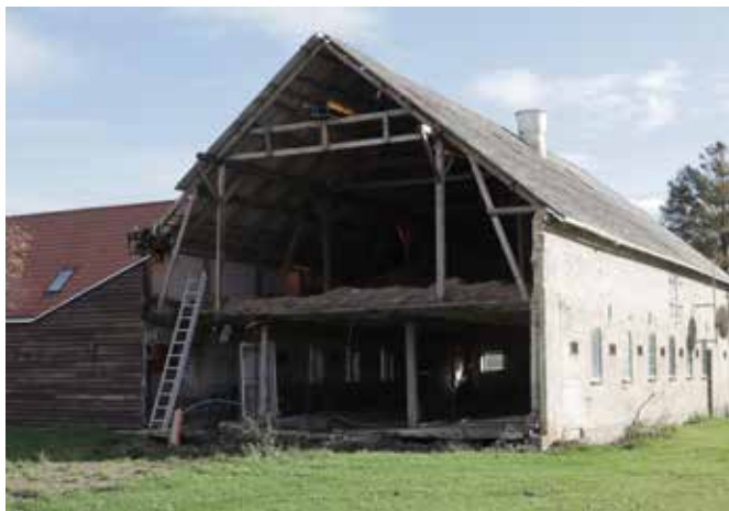
Den gamle svinestald er brækket ned og jernet er kørt til skrot. Den sidste del af stalden bliver omdannet til bolig.
