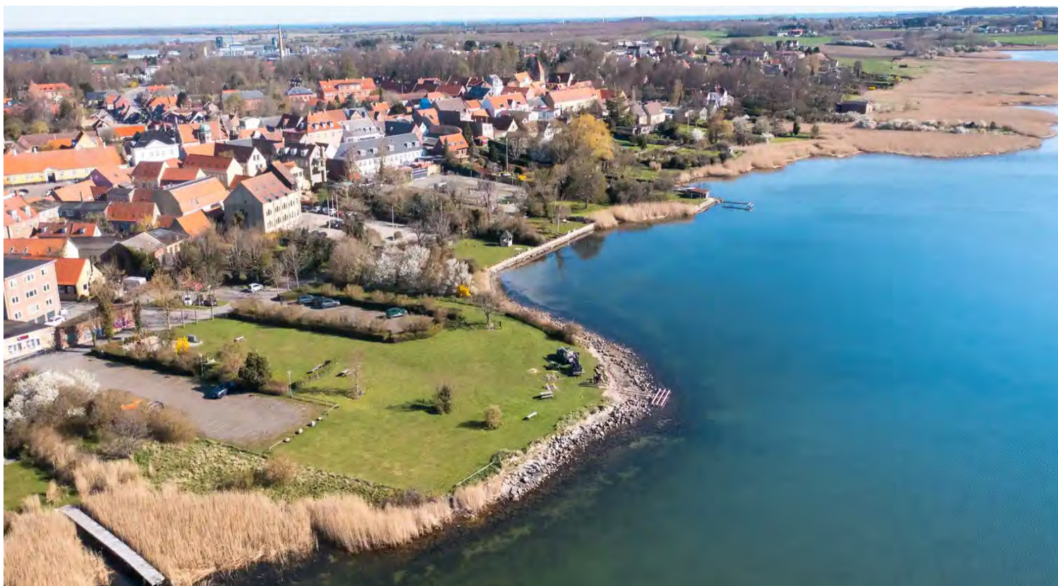
En af broerne ved Naturbaserne omkring Stege Nor under etablering. Projektet med shelters, broer og øvrige friluftsfaciliteter har været ti år undervejs.
